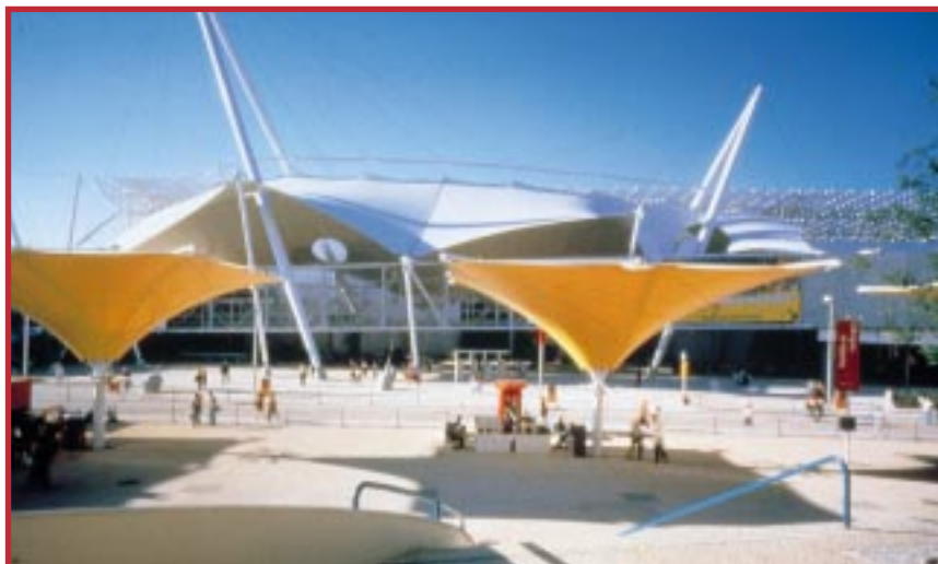
L'entrata principale dell'Expo '98 di Lisbona coperta da una tensostruttura di 4.000 metri quadrati prodotta dalla Canobbio.
